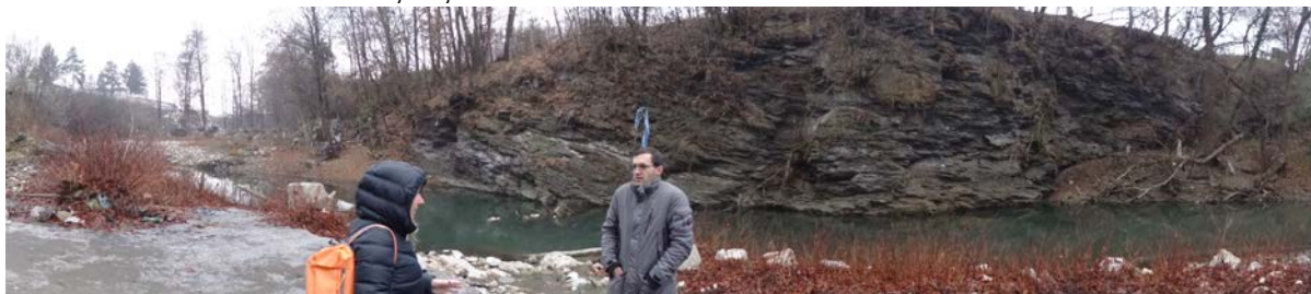
Slika br. 2 - Mesto predviđeno za pregradni profil
